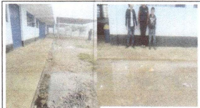
Foto 4: Reparación de plancha de concreto de patio.
